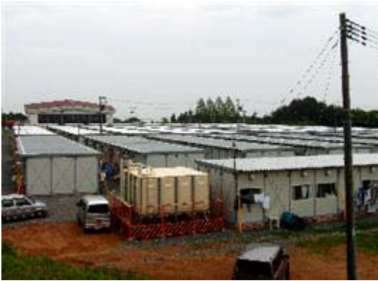
仮設住宅 260 戸が建設されたグリーンピア
