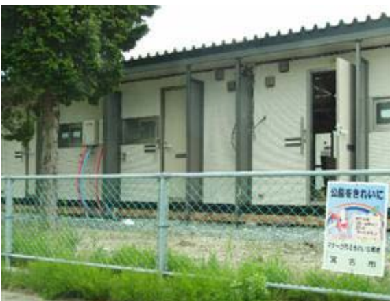
児童公園に建設された仮設住宅
