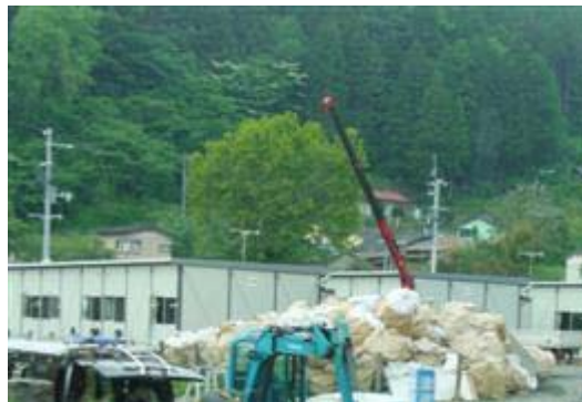
仮設の建設が始まった少し高台にある地区
